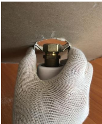
Рис. 3. Сжатие упора перед монтажом в потолок
