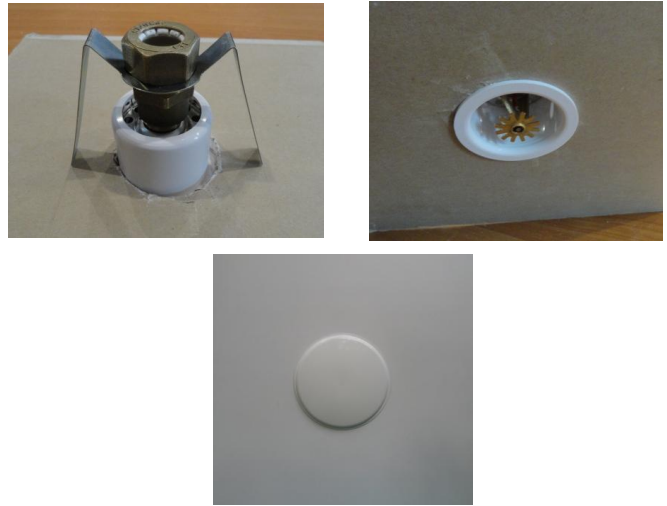
Рис. 7. Смонтированный скрытый ороситель
